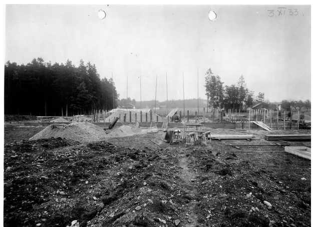
Baubeginn Mitte Oktober 1933: Erstes Bild vom Bau der Turnhalle: Nov. 1933; im Hintergrund rechts Baderhuber, links „Hois“ (jetzt Dorfner) und rechts davon Tüchler
