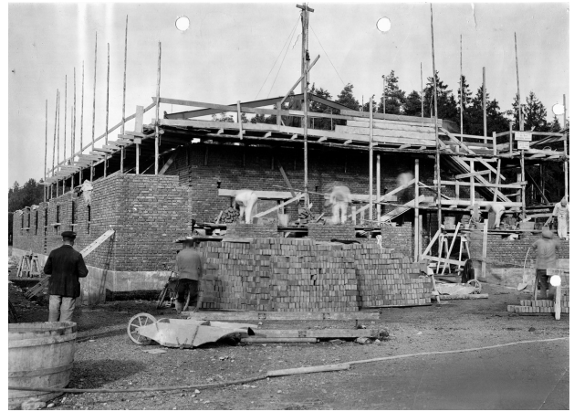
undatierte Aufnahme der Baustelle: vermutlich November 1933 mit Bauarbeitern Schilder rechts oben sind Verbotsschilder: „Jede Verunreinigung / des Baus / strengstens verboten“ und „Nichtbeschäftigten ist der Zutritt verboten“
