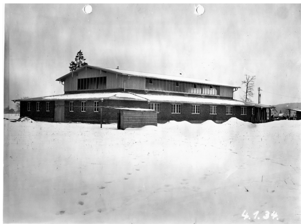
Turnhalle im Rohbau im Januar 1934;
