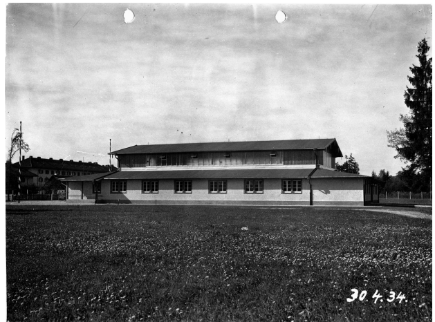
Turnhalle nach Fertigstellung: Traufseite Nord zum ehemaligen „Volksfestplatz“
