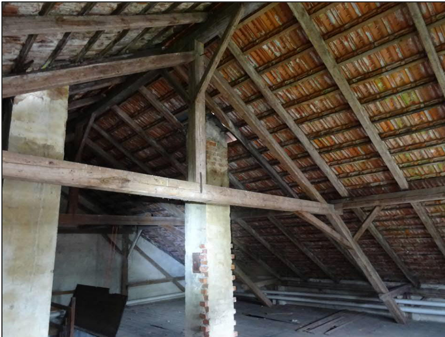
Abbildung 7 Dachraum Hauptgebäude (Wohnteil, Mai 2021)
