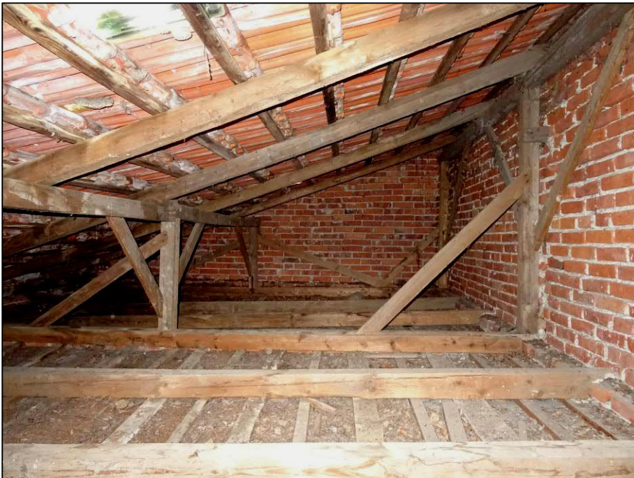
Abbildung 9 Dachraum Garage (Mai 2021)
