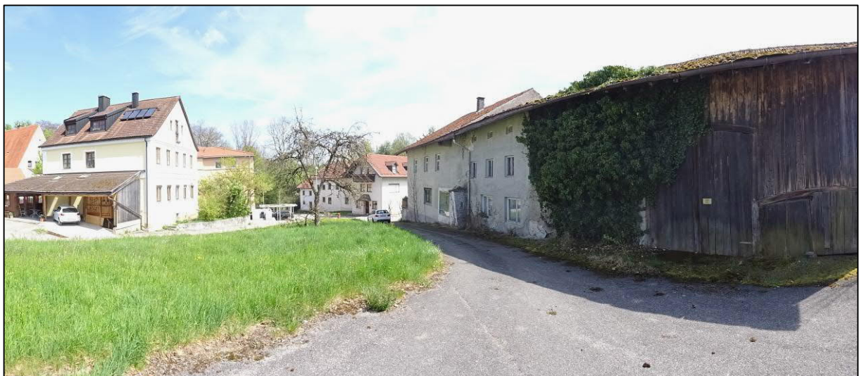
Abbildung 5 Nordseite des Bestandgebäudes mit Grünfläche und Zufahrt (Blick nach Osten, Mai 2021)
